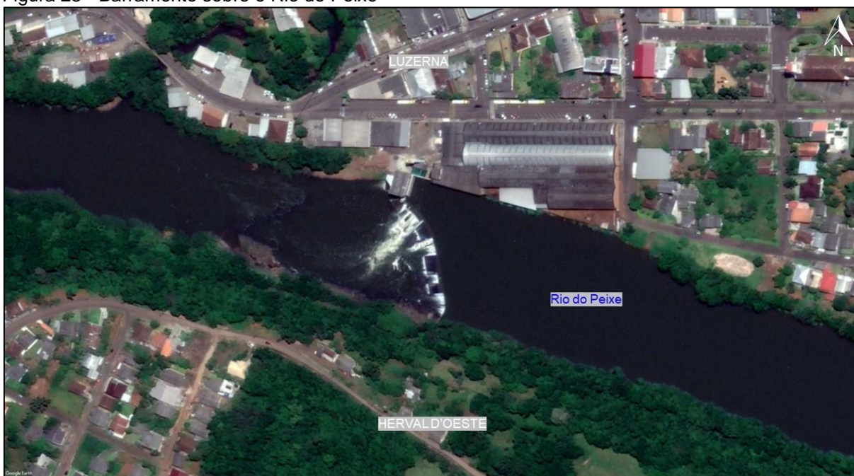
Figura 23 - Barramento sobre o Rio do Peixe
