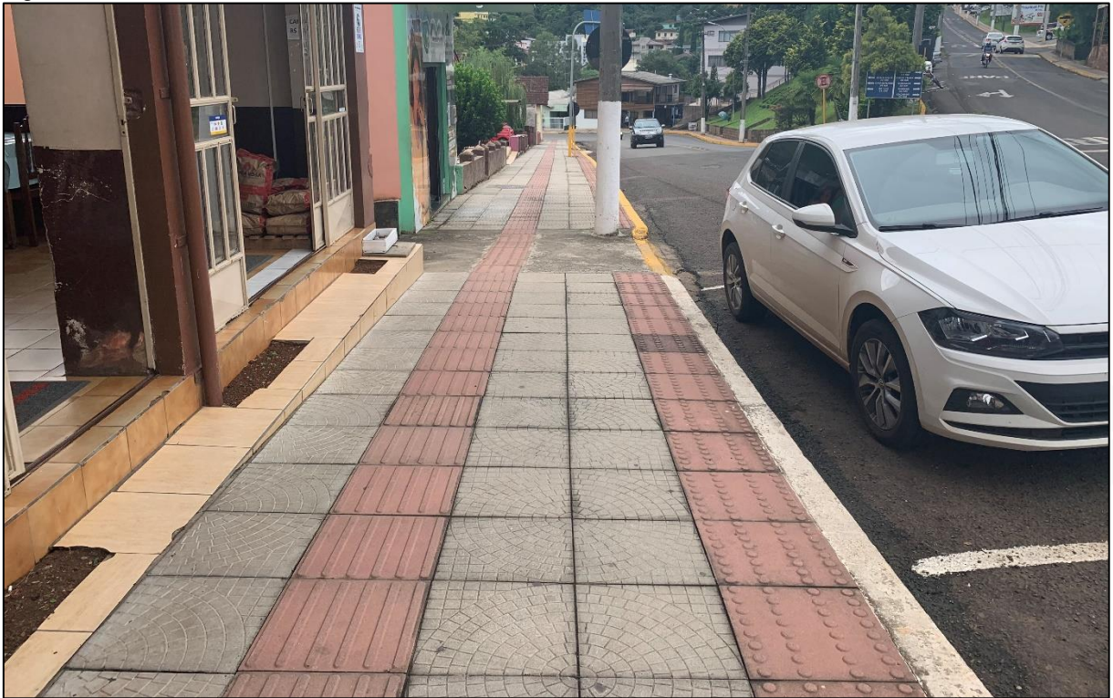
Figura 73 - Passeio Público na Avenida 16 de Fevereiro, Centro
