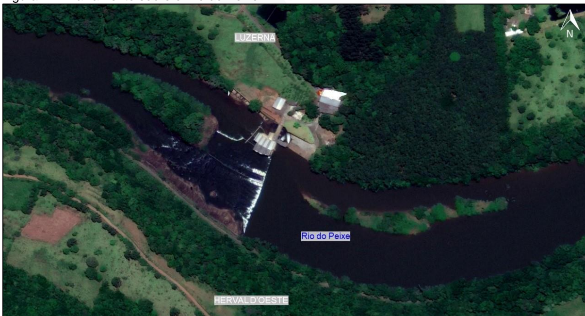
Figura 24 - Barramento sobre o Rio do Peixe
