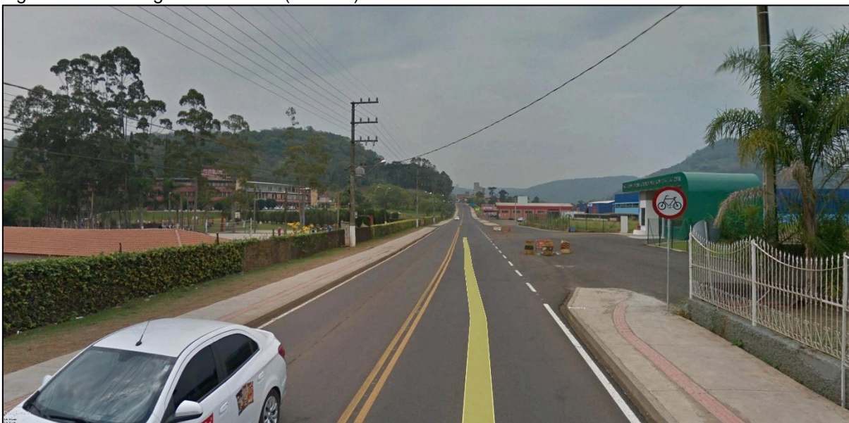
Figura 85 - Rua Vigário Frei João (SC-453)
