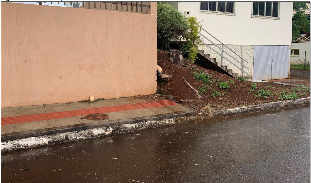
Figura 71 - Passeio público executado na Rua da Limeira
