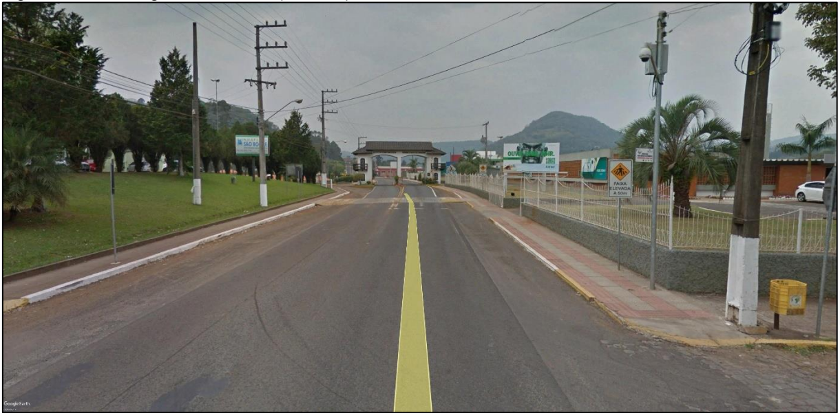
Figura 61 - Rua Vigário Frei João (SC-453)
